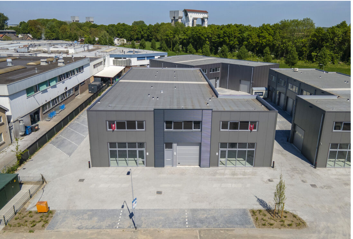
Latensteinse Middenweg 33, Tiel
