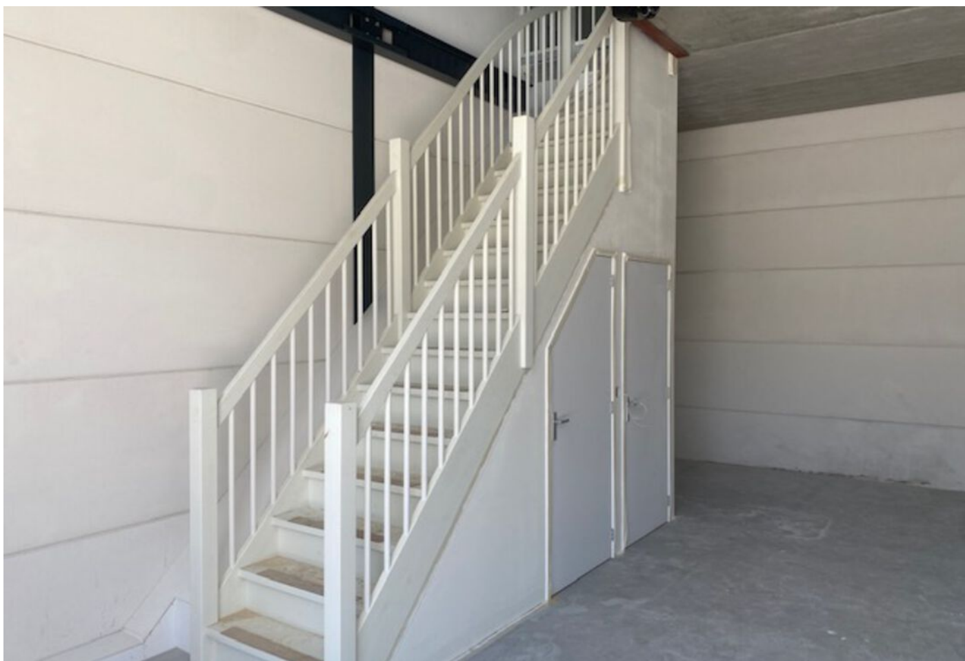
Latensteinse Middenweg 33, Tiel
